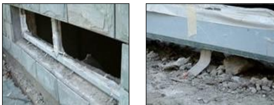
图 6-2 连接件固定
