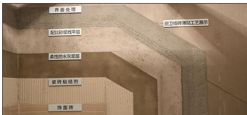
图 7-6 厨房薄贴瓷砖工艺展示图
