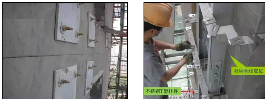
图 6-7 预埋件、连接件
